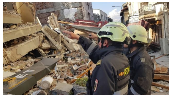
Abbildung 7: Ein Rette- und Bergeteam bei einer Schadstelle in ANTAKYA
