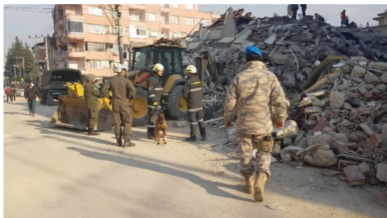
Abbildung 6: Schadstellenerkundung in ANTAKYA
