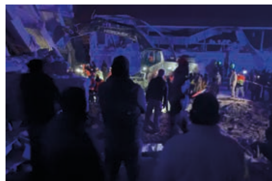
Abb. 15: Auch in der Nacht gehen die Arbeiten weiter (Bild: Bundesheer)
