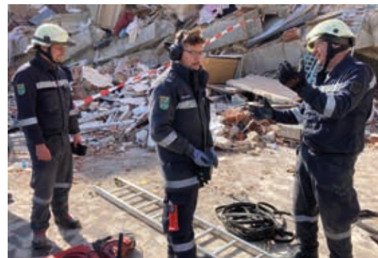
Abb. 14: Sicherheit bleibt oberstes Gebot: Beratung vor einer Schadenstelle (Bild: Bundesheer)
