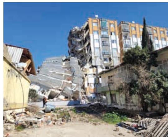
Abb. 12: Eine von zahlreichen Schadenstellen im Einsatzraum Antakya (Bild: Bundesheer)
