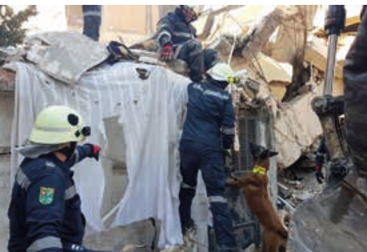
Abb. 11: Die Arbeiten an einer Schadenstelle beginnen mit der Ortung (Bild: Bundesheer)
