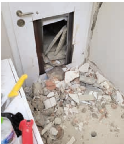
Abb. 1: Türöffnung und Bohrung für optische Ortung (Bild: Kurt Kerschbaumer)
