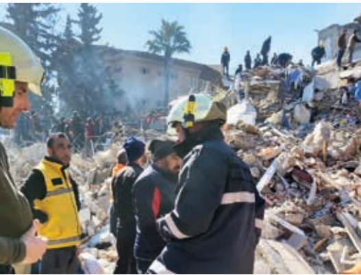
Abb. 16: Währenddessen erkundet ein anderes Rette- und Bergeteam eine weitere Schadenstelle (Bild: Bundesheer)
